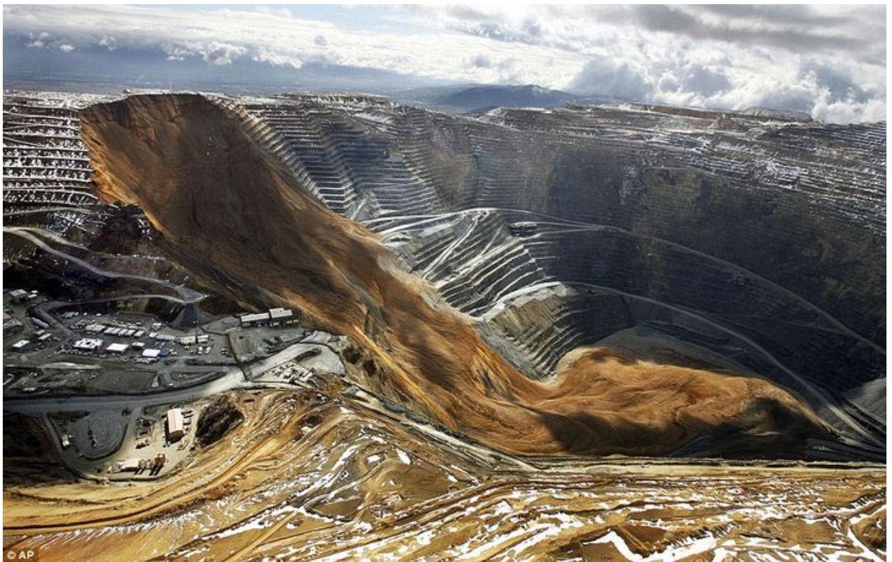
Рисунок 2.8 – Обрушение в карьере «Бингам Каньон» (США) [99]
