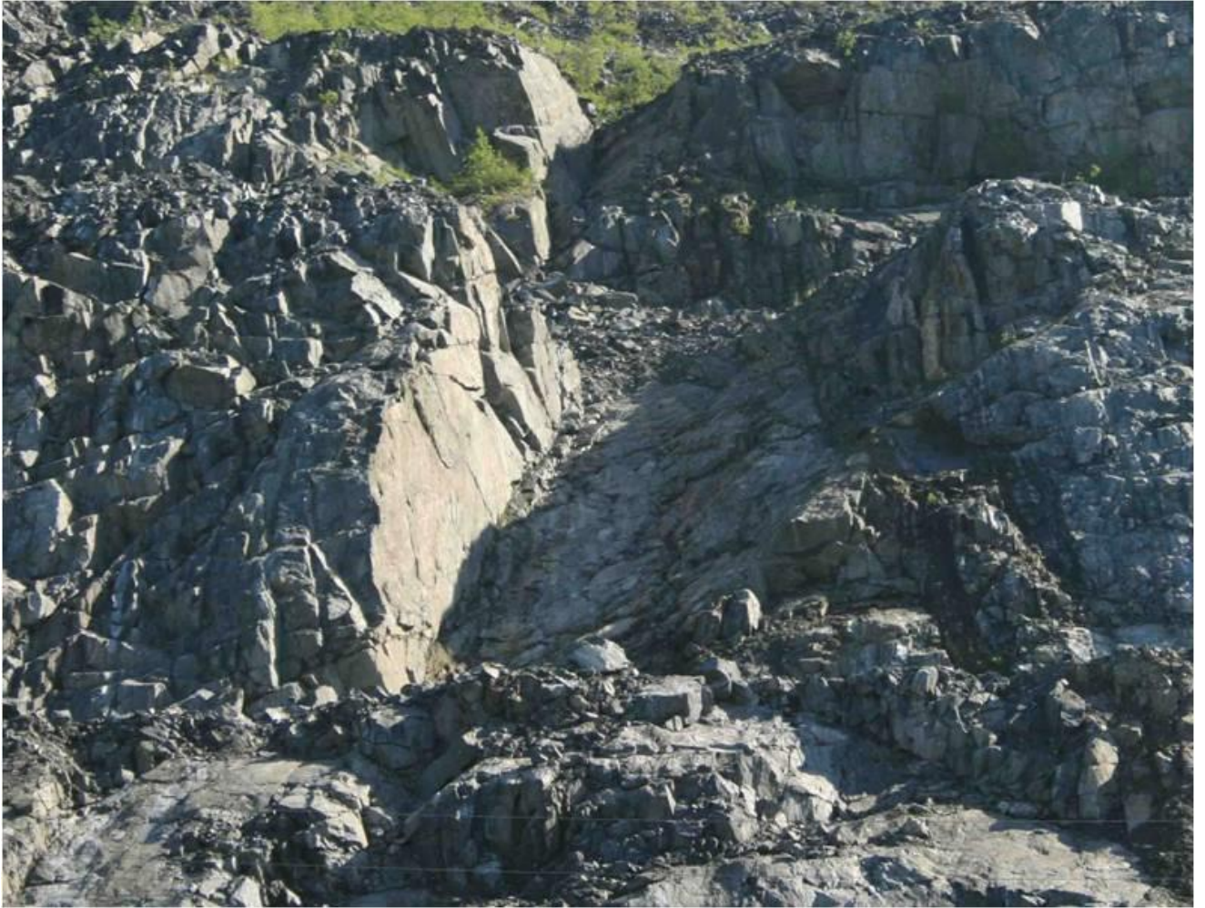
Рисунок 3.3 – Пример клиновидного (призматического) обрушения [110]
