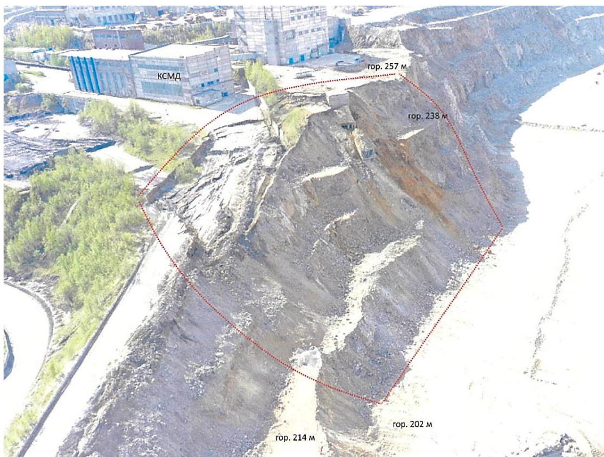
Рисунок 4.24 – Обрушение №3 в карьере «Железный» от 31 мая 2022 года
