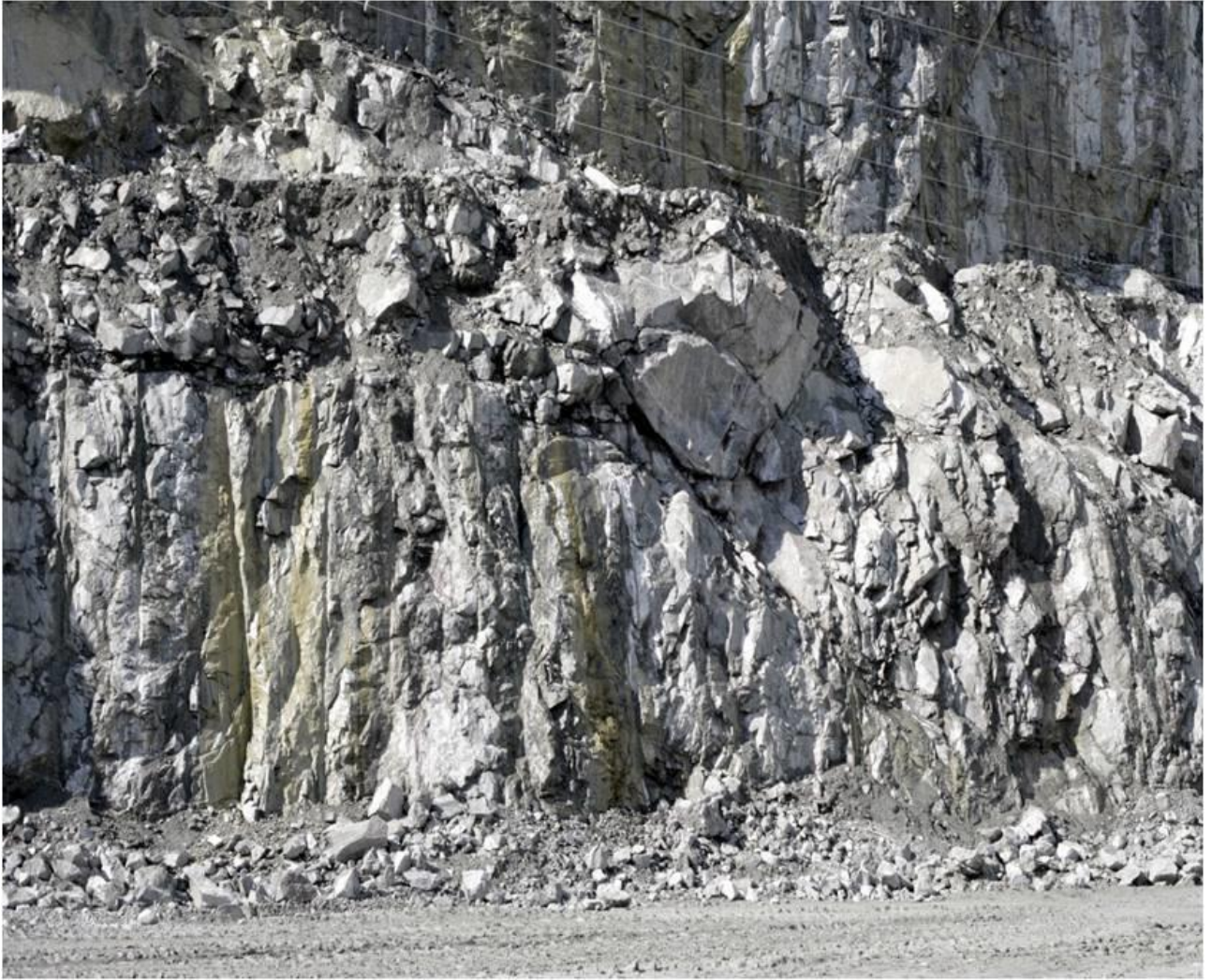
Рисунок 3.1– Пример осыпи трещиноватых и дезинтегрированных пород [110]
