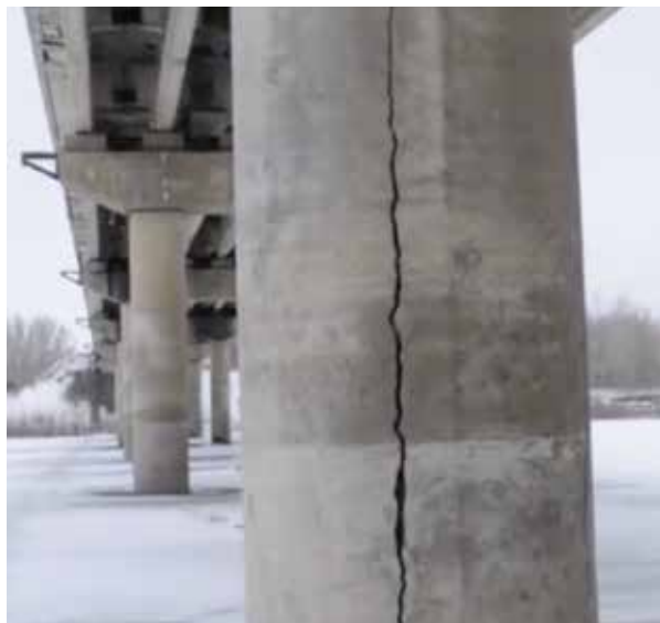
Рис. 1. Пример конструкции с изломом профиля и трещиной для численного анализа на основе разработанного весового метода конечных элементов
