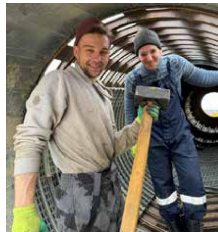
Журавлев Кирилл и Васюта Алексей. Монтаж ПБШ-100 на россыпном месторождении
