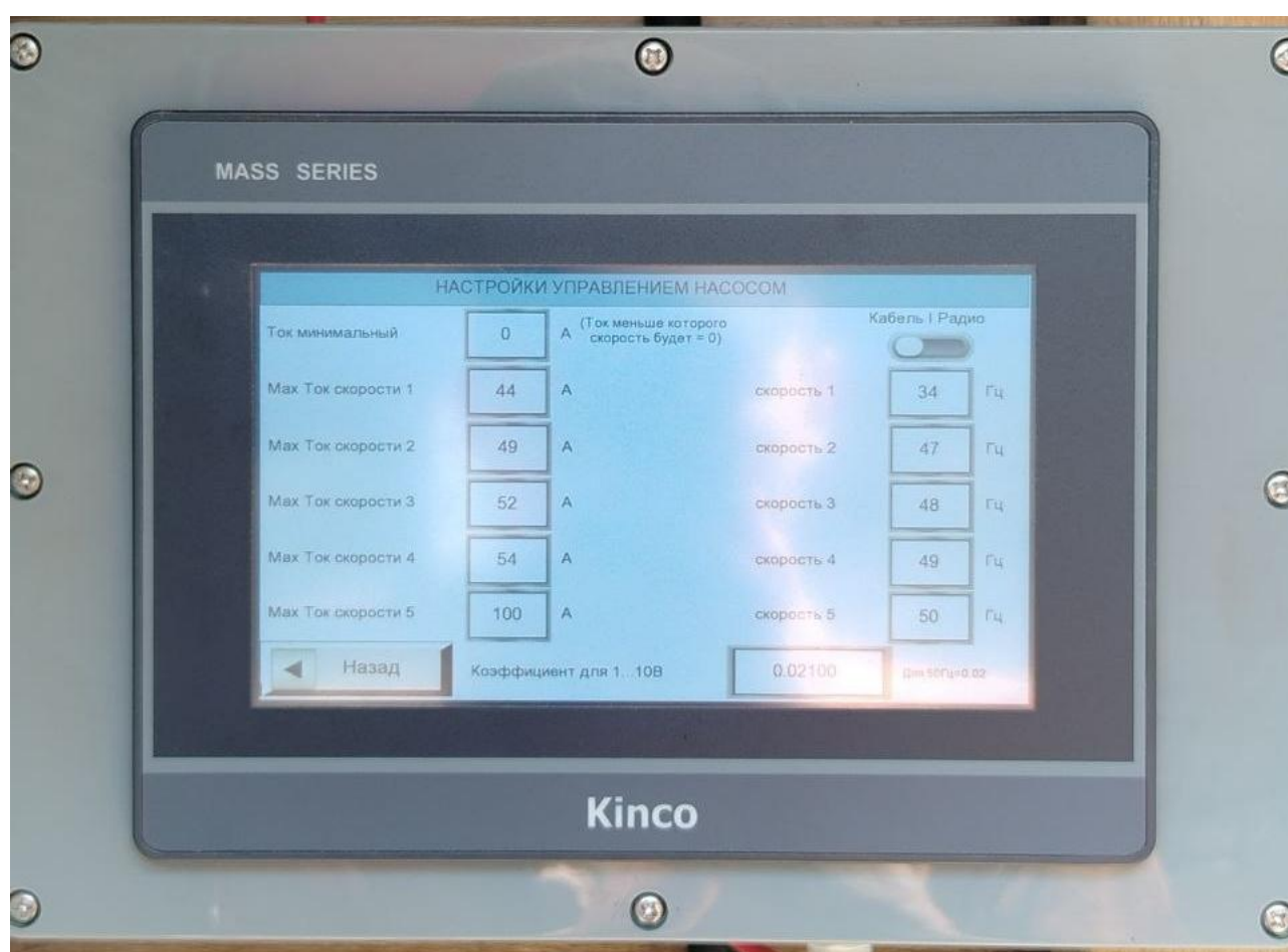
Рисунок 3.6 – Панель оператора (меню настройки насоса)
