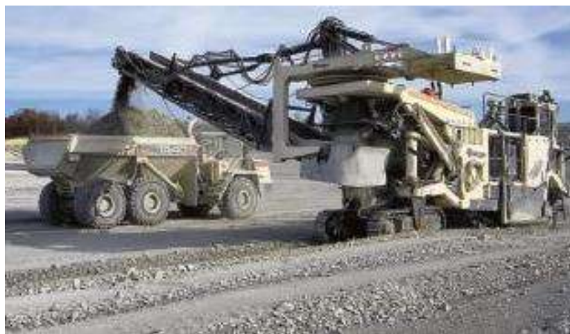
Рисунок 1.17 – Комбайн Wirtgen 2500SM ведет погрузку автосамосвала
