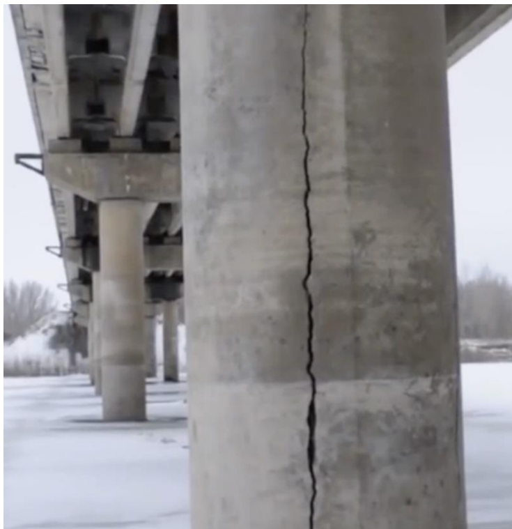
Рис. 6. Пример конструкции с изломом профиля
